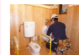
住設機器等取付け
