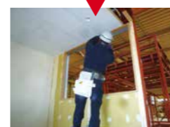
鋼製建具取付け
