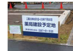
工事看板設置
